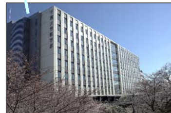
医学部(新) 医学系総合研究棟 (治療学研究棟)
